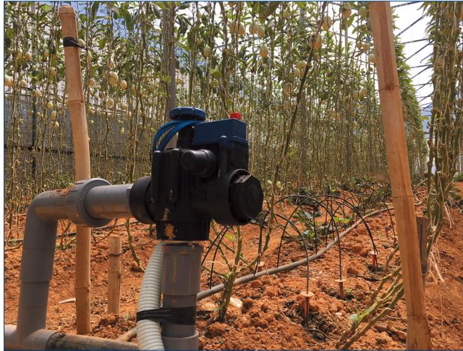
図4. ベトナム ダラット高原の電磁弁をインターネット経由で日本より制御
