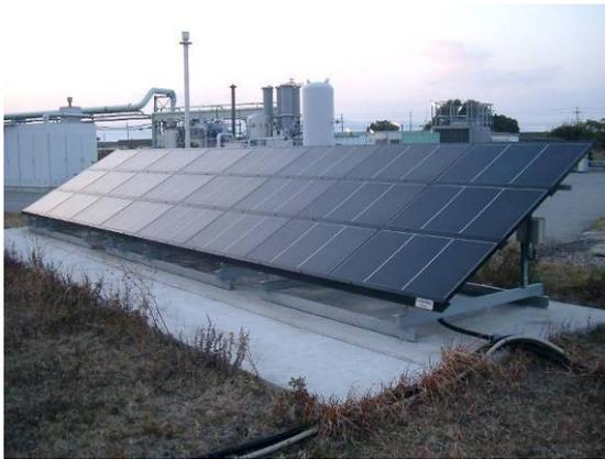
図 3-22 電力実験場・太陽電池（3kW）
