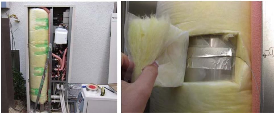
図 3-28 燃料電池貯湯槽熱量把握のための温度センサー取り付け状況
