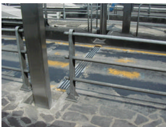
車両の通過を感知するセンサー
